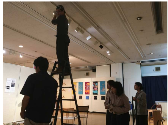
ミュージアムライトの取り付け作業
